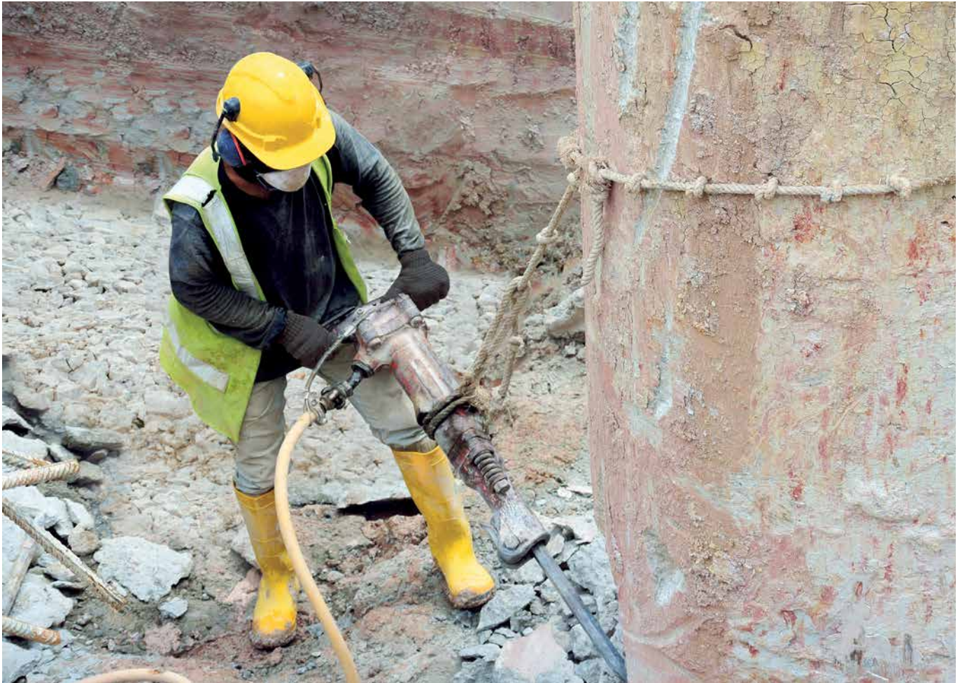
Lärmschwerhörigkeit kann beispielsweise durch häufiges Arbeiten mit lauten Geräten wie Druckluflhämmern oder Kreissägen verursacht werden.
